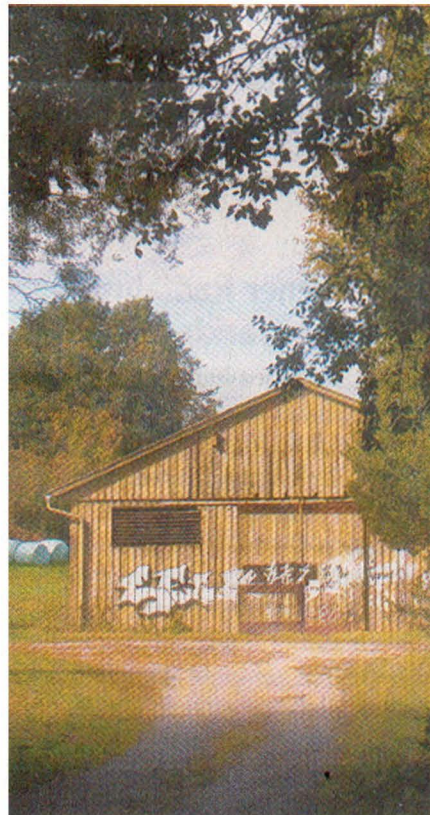
An der Lagerhalle zwischen Hammel und Ottmarshausen könnte ein Grillplatz entstehen. Foto: Marcus Merk
